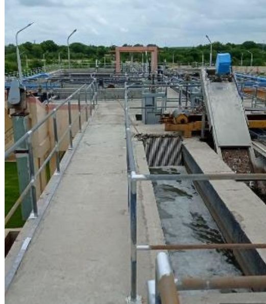
65 MLD STP LALTIPARA
