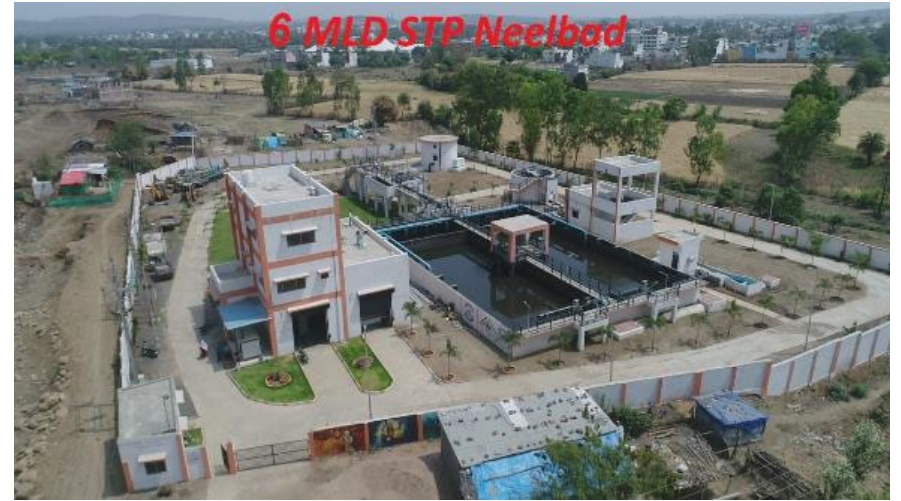
6 MLD STP IN NEELBAD
